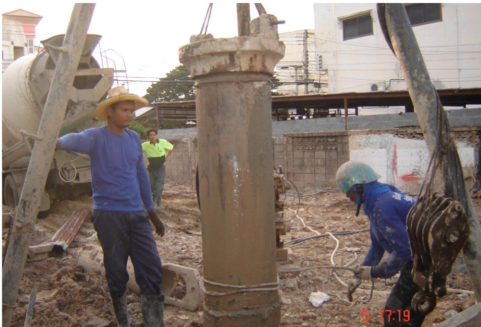
รูปที่ 2.35 EXTRACT CASING OUT การถอนปลอกเหล็ก
