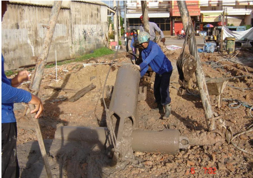
รูปที่ 2.32 BORE OUT TO CLAY BED การที่ดินออกจากกระเช้า
