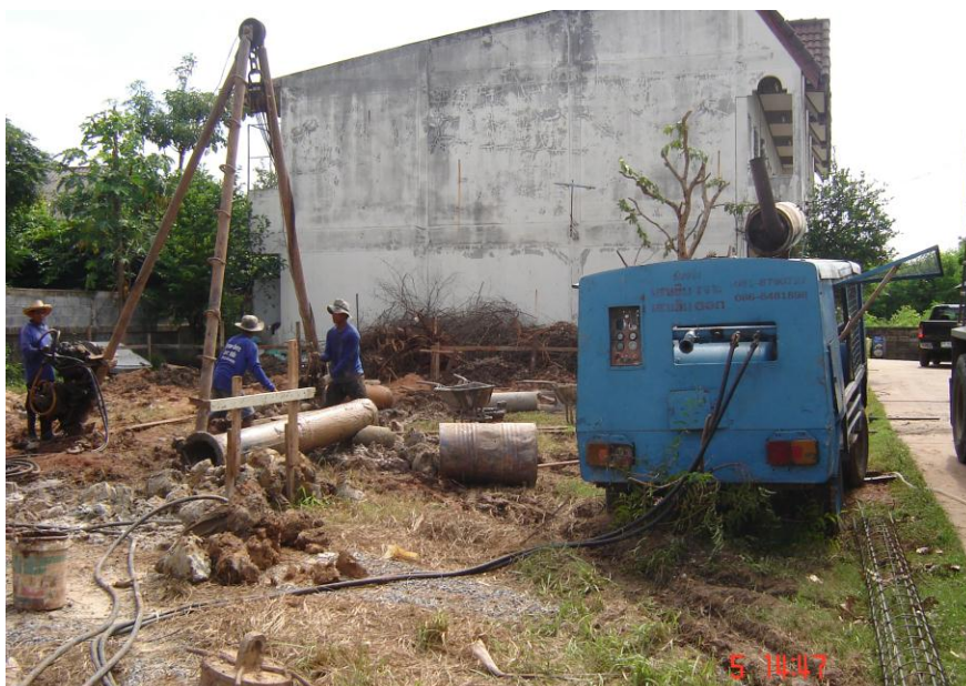
รูป 2.30 ขาหยั่งเหล็ก 3 ขา ปลายติดรอกเดี่ยว (Tripod Rig) เครื่องกว้านลม (Air Winch)
